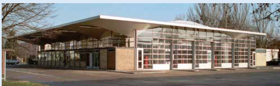
Die Prüfhalle auf dem ehemaligen Gelände des Technischen Überwachungsamts. Bild aus dem Jahr 2010.
