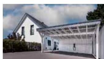
Foto: epr/Solarterrassen & Carportwerk GmbH
