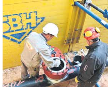
Planen, Absperren und Anbohren: Die e-netz Südhessen ist Experte für die fachgerechte und zeitsparende Stoppelung von Gashochdruckleitungen ohne Versorgungsunterbrechung.
