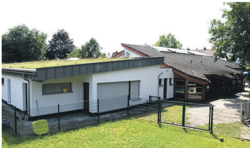
Der Evangelische Kindergarten in Alheim, fotografiert vom Hügel des benachbarten Spielplatzes aus. In den kommenden Wochen wird die Einrichtung weitgehend verwaist sei, weil das Dach saniert wird. Der Ausweichstandort steht bei den Eltern in der Kritik. (Foto: jedö)
