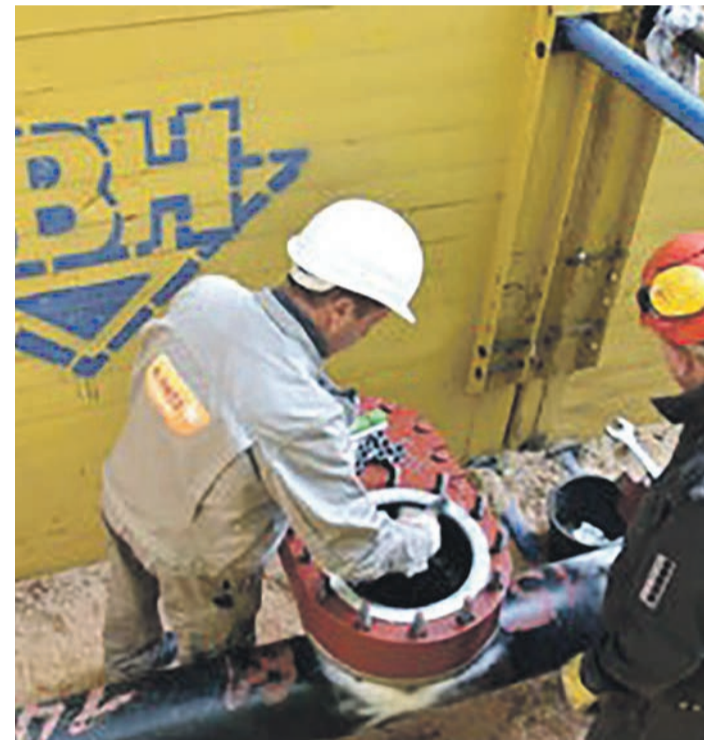
Planen, Absperren und Anbohren: Die e-netz Süd-hessen ist Experte für die fachgerechte und zeitsparende Stoppelung von Gashochdruckleitungen ohne Versorgungsunterbrechung (Foto: E-Netz)
