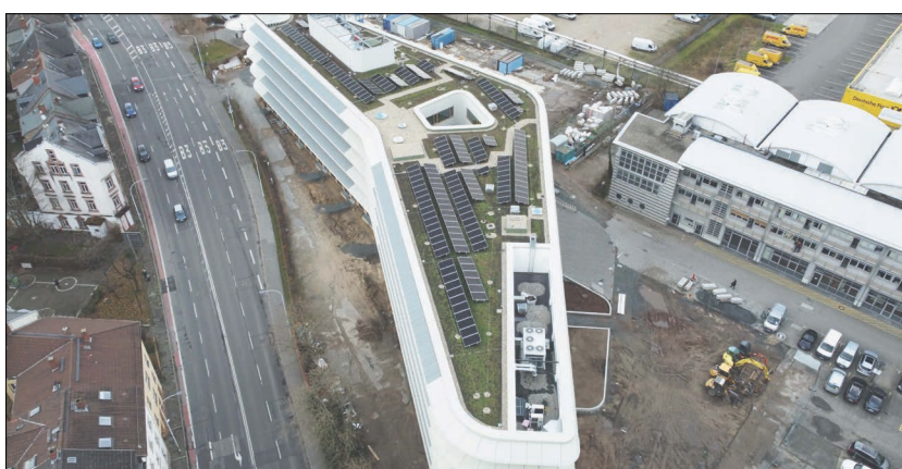
Die PV-Anlage erzeugt voraussichtlich ca. 73.000 Kilowattstunden (kWh) Strom pro Jahr. Foto: ENTEGA
