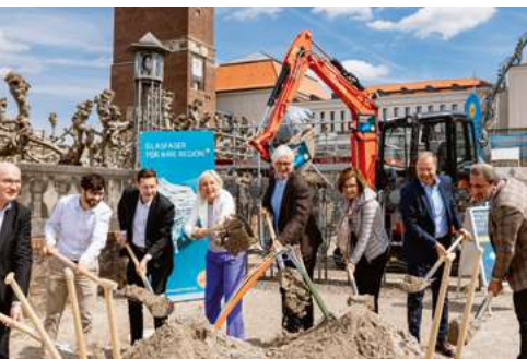
ENTEKA setzt den Ausbau des Glasfasernetzes planmäßig um.
