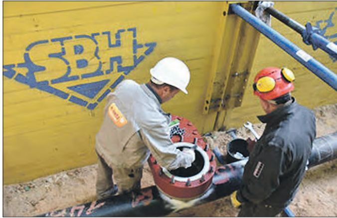
Die e-netz Süd Hessen ist Expertin für die fachgerechte und zeitsparende Stoppelung von Gashochdruckleitungen ohne Versorgungsunterbrechung. Foto: E-Netz
