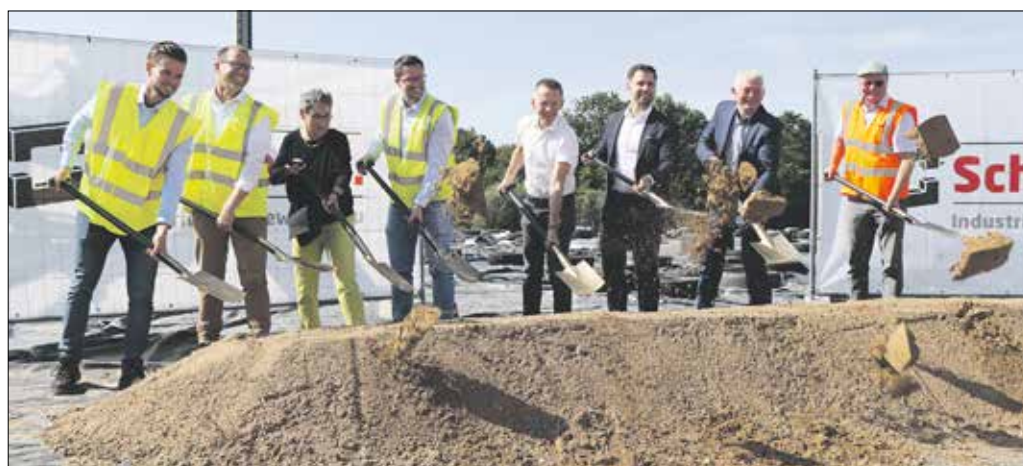
Spatenstich für die Bioabfallvergärungs- und Kompostierungsanlage auf dem Gelände des Büttelborner Abfallzentrums war in der vergangenen Woche.
