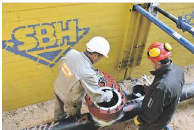
Die e-netz Süd Hessen ist Experte für die fachgerechte und zeitsparende Stoppelung von Gashochdruckleitungen ohne Versorgungsunterbrechung. Foto: E-Netz
