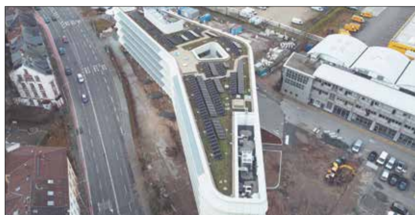
Die PV-Anlage erzeugt voraussichtlich ca. 73.000 Kilowattstunden (kWh) Strom pro Jahr. Foto: ENTEGA
