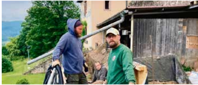
Sanierung auf Reichenberg fast abgeschlossen Seite 6
