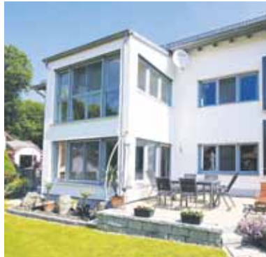
Gesunde Raumluft mit der Kraft der Sonne: Eine solare Lüftung lässt sich bei wenig Aufwand einfach raumweise nachrüsten.
