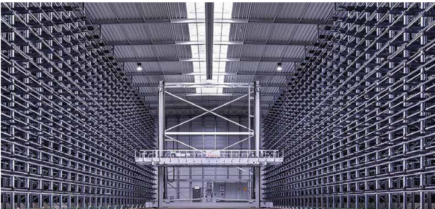
Automatisches Hochregallager des Kunden VOL-Stahl in Hanau.
