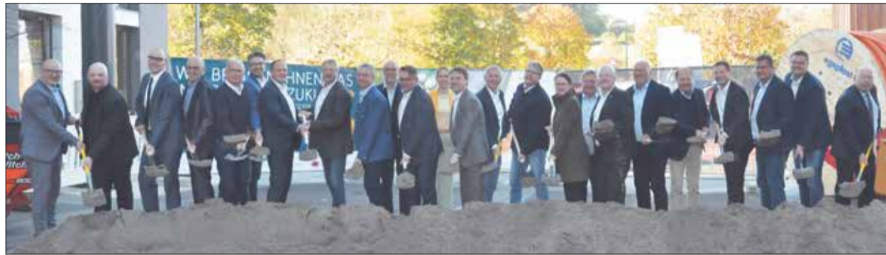
Spatenstich für den geförderten Glasfaserausbau im Odenwaldkreis: Die Vertreter der Odenwälder Kommunen, die beiden Vertragspartner Odenwald Gigabit Gesellschaft mbH und PEB Breitband GmbH & Co. KG sowie Vertreter von Bund und Land Foto: OGIG mbH
