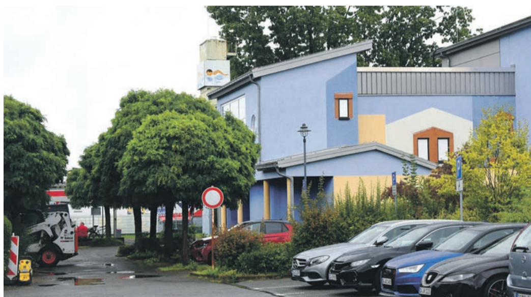
Seit Sommer 2019 ist das Münsterer Hallenbad geschlossen und soll abgerissen werden. Eventuell könnte auf dem Grundstück ein Wohngebiet samt kleinem Bad entstehen, Nun gibt es dazu zwei neue Vorstöße. (Foto: jedö)
