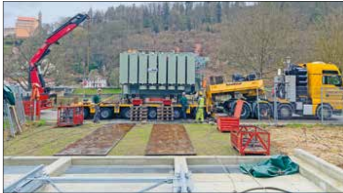
Ein Spezial-Schwertransport brachte den Transformator über die kurve und teilweise beengte Strecke sicher ans Ziel.
