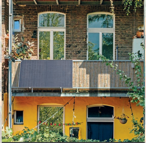
Einer Umfrage zufolge war das Interesse an Balkonkraftwerken schon vor der Verabschiedung des Solarpakets I groß - das neue Gesetz sieht einen Bürokratieabbau vor und wird die Nachfrage weiter erhöhen. Foto: djd-k/www.yuma.de
