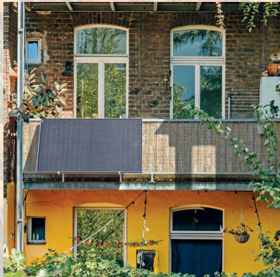
Einer Umfrage zufolge war das Interesse an Balkonkraftwerken schon vor der Verabschiedung des Solarpakets I groß - das neue Gesetz sieht einen Bürokratieabbau vor und wird die Nachfrage weiter erhöhen. Foto: dj-d-k/www.yuma.de
