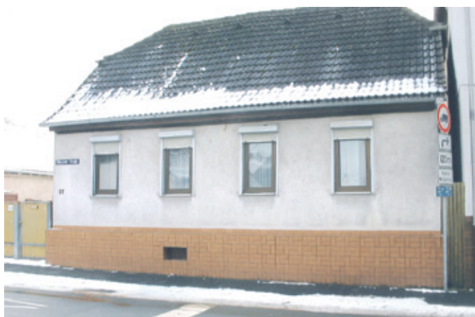
Altes Haus mit langer Geschichte – Arheilgen, Messeler Str. 57 (früher Dieburger Str.). Es ist das Elternhaus meines Großvaters – Heinrich Stork (1839–1926). Die Gastwirtschaft „Goldener Stern“ seines Vaters – Johann Philipp Stork (1791–1869, Schneidermeister) befand sich damals in diesem Haus. Nun wurde das Gebäude 2024 abgerissen und ein weiterer Teil von Alt-Arheilgen ist verschwunden. Ingeborg Hundsdorf
