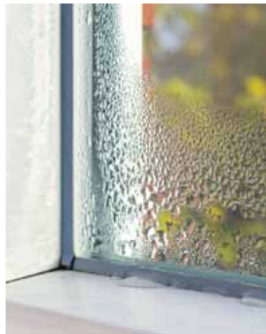
Feuchtigkeit in der Wohnung und als Ergebnis ein erhöhter Energiebedarf: Ein Austausch alter Dichtungsprofile ist dann oftmals unerlässlich.
