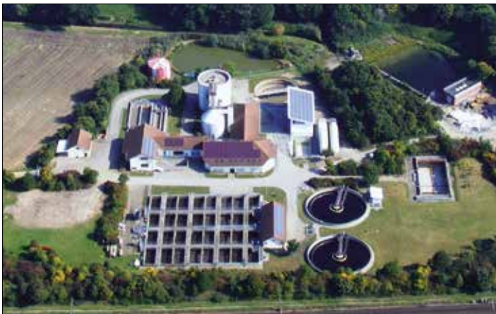
Die Zentralkläranlage in Goddelau
