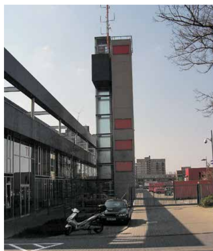
Nordseite mit Turm der Bereichsleitungswache 1 im Bkrz.
