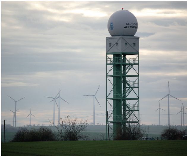
Abbildung 2-7: Radar Ummendorf (UMD) mit Windkraftanlagen im Hintergrund. Windkraftanlagen können zu Störechos führen, die bei sich drehenden Rotorblättern bisher nicht herausgefiltert werden können (Foto: B. Lange, DWD).
