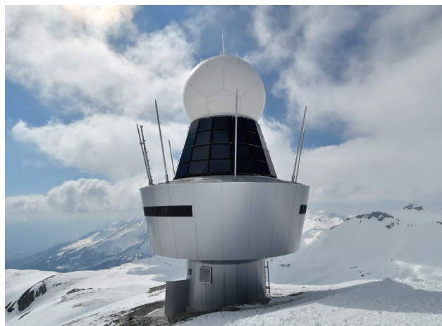
Abbildung 7-1: Wetterradar in der Südwestschweiz auf der Pointe de la Plaine Morte auf 2937 Metern über Meer.
