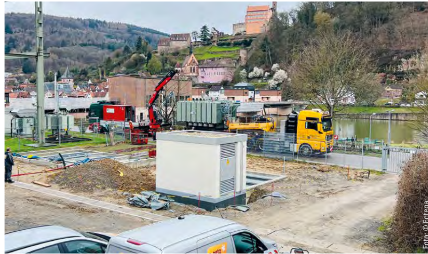
Ein Spezial-Schwertransport brachte den Transformator über die kurvige und teilweise beengte Strecke sicher ans Ziel.
