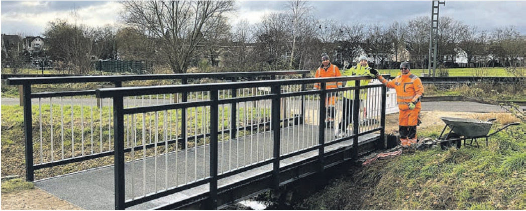
Mitarbeiter des städtischen Betriebshofes und der Firma BGL Ingenieurbau haben die neuen GFK-Brückenelemente am Rand der Rennwiesen-Siedlung montiert. (Foto: Stadt)
