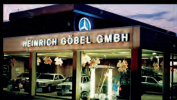
1997 Die letzten Aufnahmen des Standortes in Neu-Isenburg vor dem größtflächigen Umbau und Anbau.
