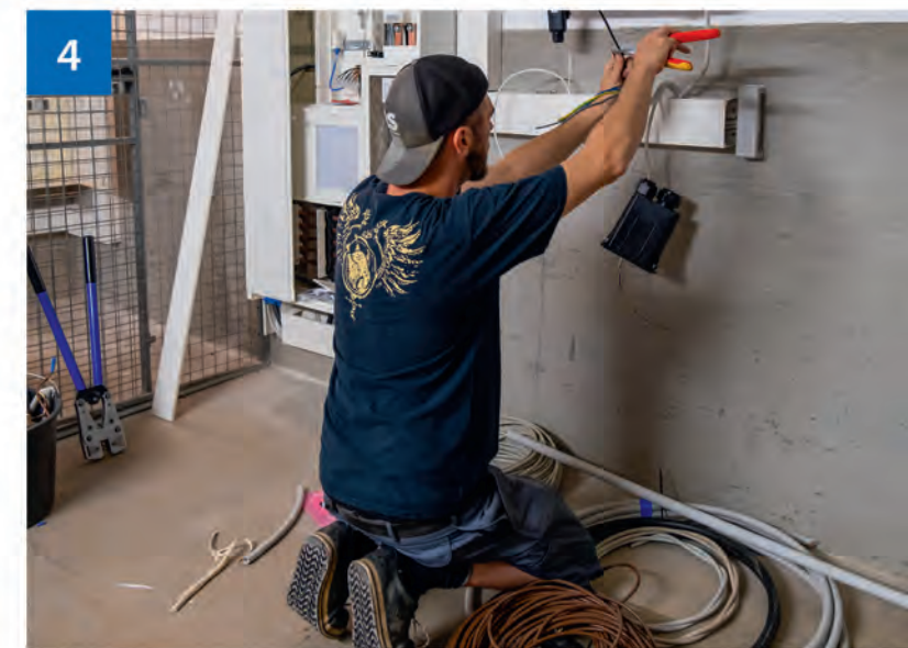
Die Solarmodule werden an das Hausnetz angeschlossen.
