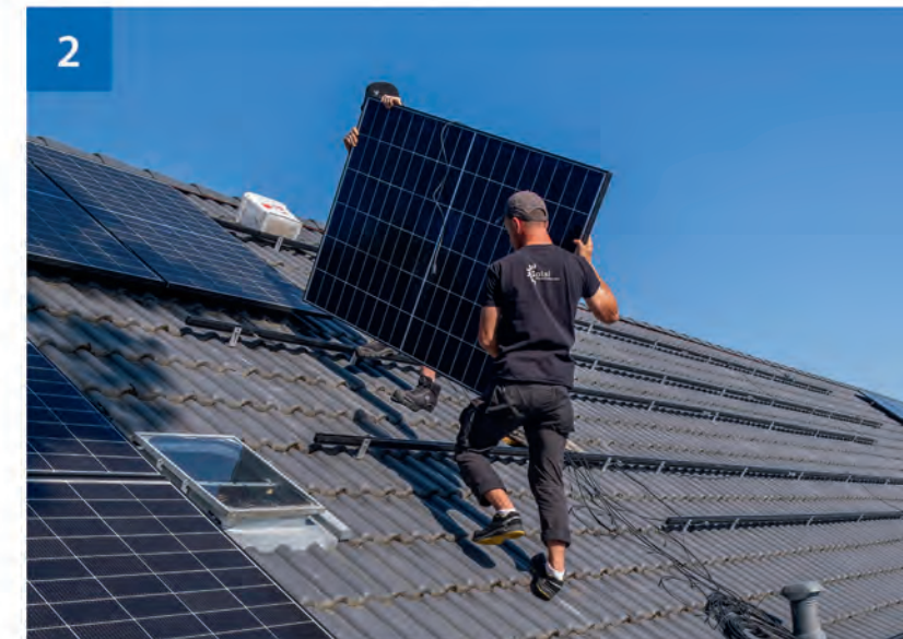
Nach dem Anbringen der Montageschienen werden die Module sicher auf dem Dach fixiert.
