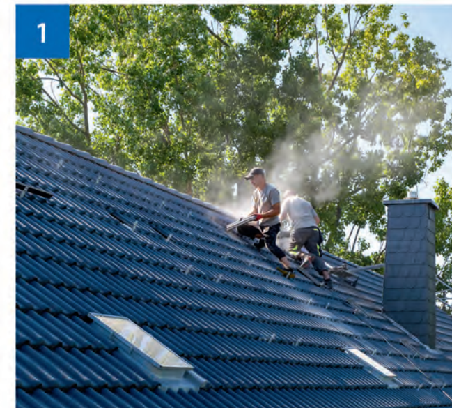
Auf dem Dach werden Dachhaken angebracht, welche die Montageschienen, auf die später die Solarmodule geklemmt werden, mit der Dachhaut verbinden.
