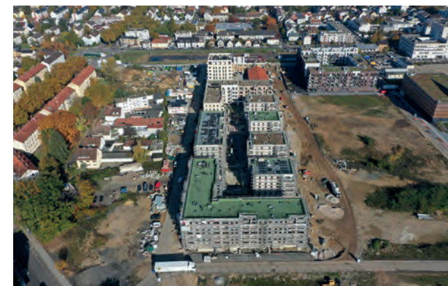
Stand der Bauarbeiten Ende Oktober 2024
