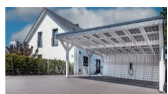
Foto: epr/Solarterrassen & Carportwerk GmbH
