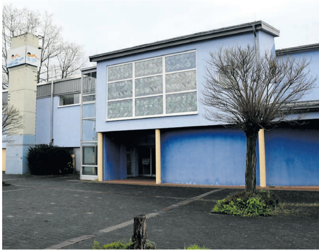
Das Areal mit dem alten Münsterer Hallenbad dient derzeit im Wesentlichen als Parkplatz und als Interimsdomizil der Kita Sonnenblume. Zudem wird das Blockheizkraftwerk im Bad noch in der benachbarten Kita „Haus der Kinder“ genutzt. Nun sind die Gemeinde und ein Projektentwickler mit großen Neubau-Plänen an die Öffentlichkeit gegangen. (Foto: jedö)
