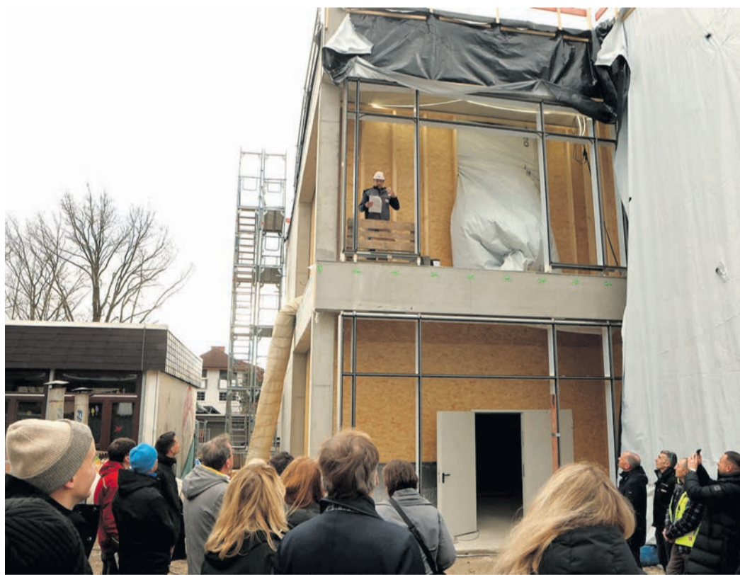
Ingo Floch von der Firma Ed. Züblin AG war für den Richtspruch zuständig.
