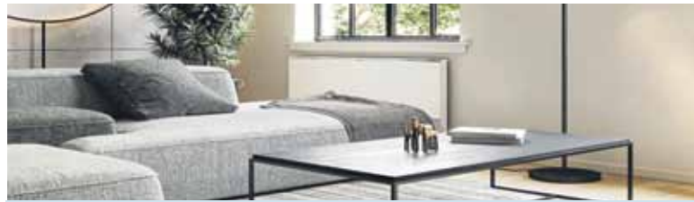
Tiefemperaturheizkörper kommen schon mit 35 Grad Vorlauftemperatur aus und sind bei gleicher Größe deutlich effizienter als herkömmliche Geräte. Foto: djd-k/www.jaga.com
