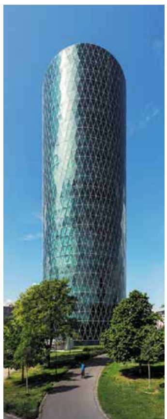
Blick von Osten auf den Westhafentower FOTO: DXR, CC BY-SA 4.0
