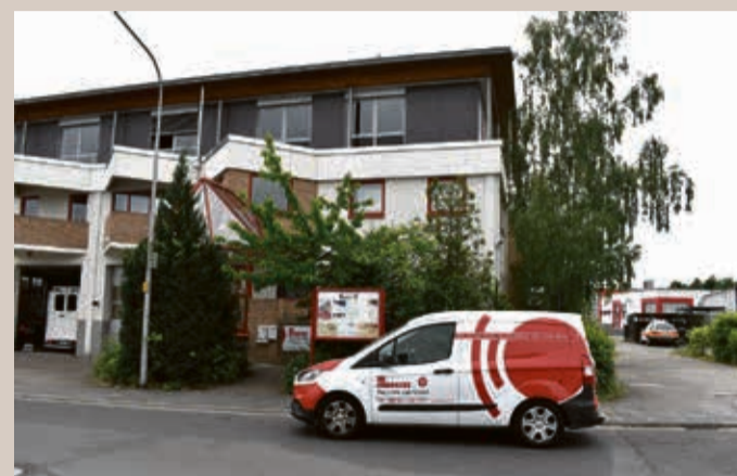
Die Johanniter-Unfallhilfe in Nieder-Roden mit Qualitäts-Fenstern mit Wärmeschutzglas. Foto: Sommer Fenster
