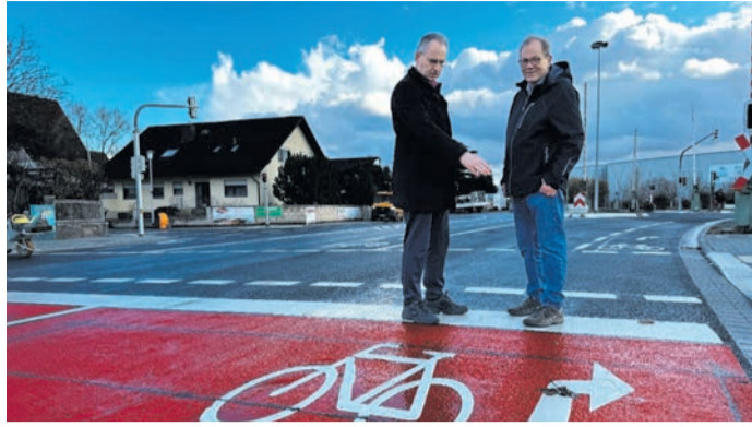
Bürgermeister a.D. Carsten Helfmann und 1. Beigeordneter Stephan Brockmann bei der Besichtigung der Baustelle am Knotenpunkt kurz nach der Eröffnung. (Foto: Gemeinde)
