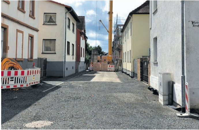
Während und nach der Umbauphase.
