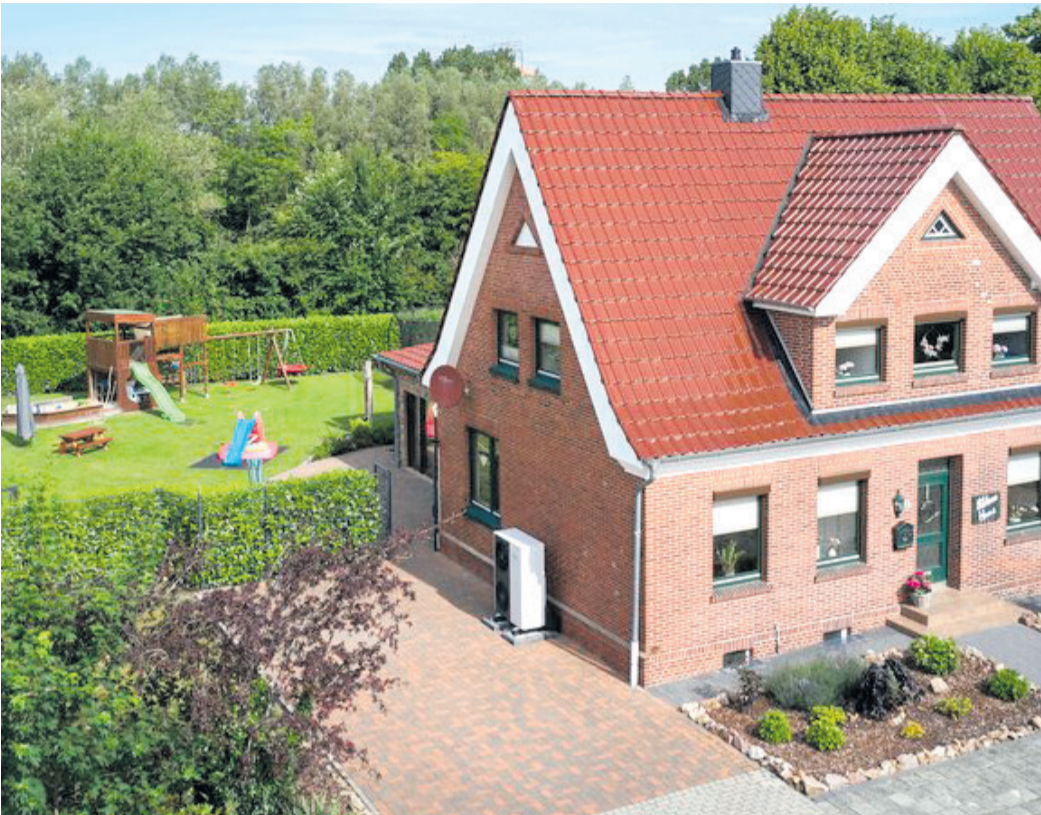
Effizient und umweltfreundlich heizen: Der Umstieg auf eine Wärmepumpe ist eine lohnende Investition – bis zu 70 Prozent der Kosten übernimmt aktuell der Staat. Foto: djd/Vaillant/Bernd Gabriel
