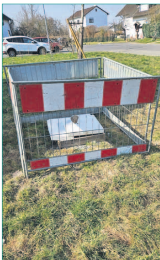
Der Standort mit dem bereits erstellten Fundament im Bereich der Grünanlage am Trinkborn.
