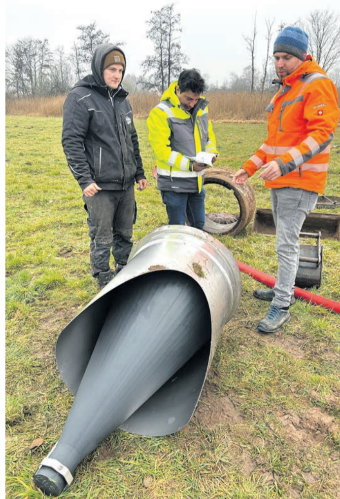
Tiefbauingenieur Babak Rafiei (Gemeinde Münster) bespricht mit den Arbeitern die Vorgehensweise der neuen Rückstauklappe. (Foto: GM/ Lena Brunn)
