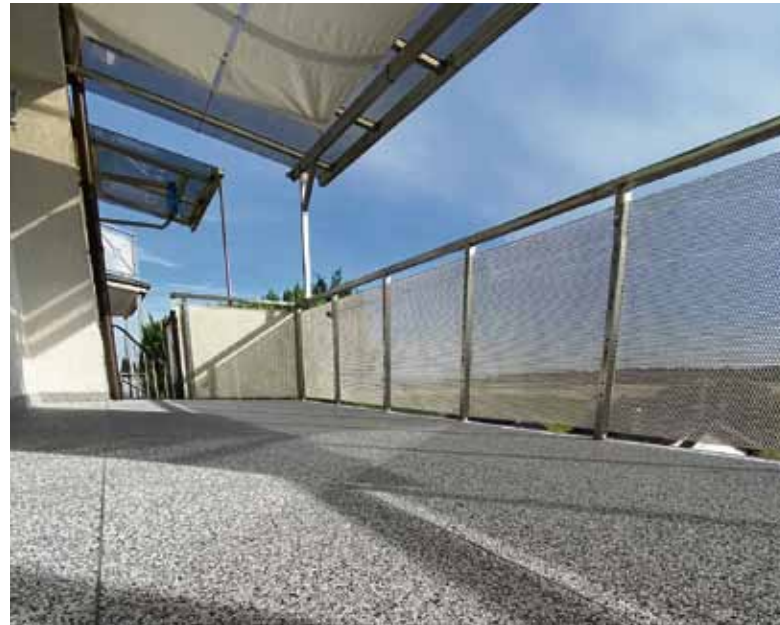
Neuer Glanz für ältere Balkone: Eine Sanierung des Belags wertet den Außenbereich sichtbar auf.
