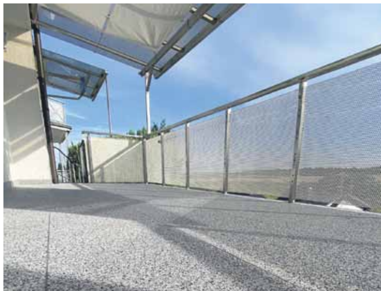
Neuer Glanz für ältere Balkone: Eine Sanierung des Belags wertet den Außenbereich sichtbar auf.
