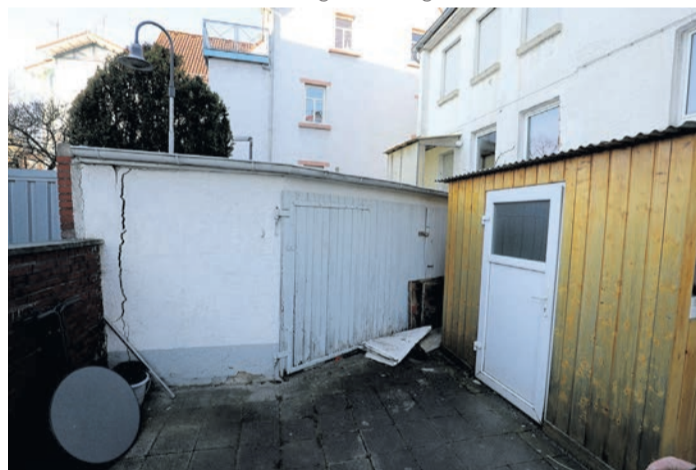
Im Jägerhaus selbst sind die Lagerbedingungen gut. Etwas Sorge bereitet der Stadt die Garage, wo an einigen Kisten Schimmelschäden festgestellt wurden.
