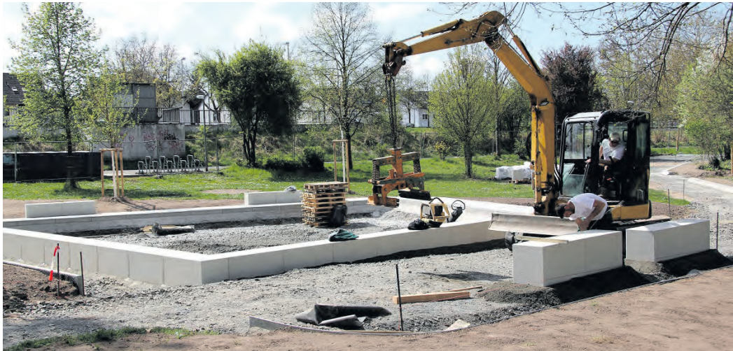
Die Arbeiten zur Aufwertung des Parks am Entenweiher sind in vollem Gange. Das Bild zeigt das Hantieren mit Elementen am Spielplatz der Zukunft, einem Herzstück der knapp 1,5 Hektar großen Grünzone. (Foto: Stadt Rödermark)
