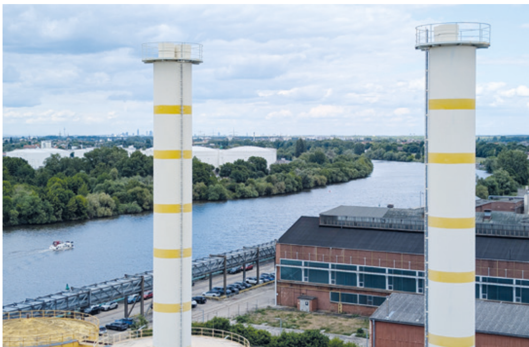
Ausblick vom Kesselhaus der GuD-Anlage im Kraftwerk auf dem ehemaligen Opel-Gelände: Im Vordergrund sind die beiden Schornsteine des Heizwerks zu sehen – im Hintergrund erahnt man die Skyline von Frankfurt. (Foto: Carmen Diesner)
