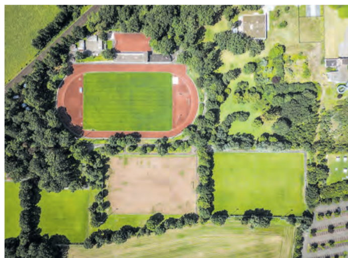
Blick von oben: Im Sportzentrum Badstraße wird demnächst ein neuer Kunstrasenplatz entstehen und der brachliegende Tennensplatz ersetzt.
