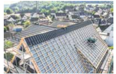
Bei einer energetischen Modernisierung oder Dachsanierung sollte der sommerliche Hitzeschutz mit beachtet werden. Foto: DJD/puren
