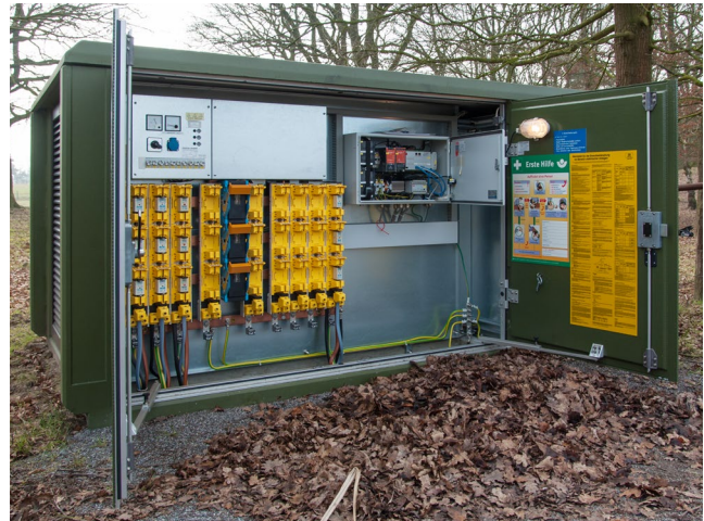
Bild 1: Typische Ortsnetzstation
