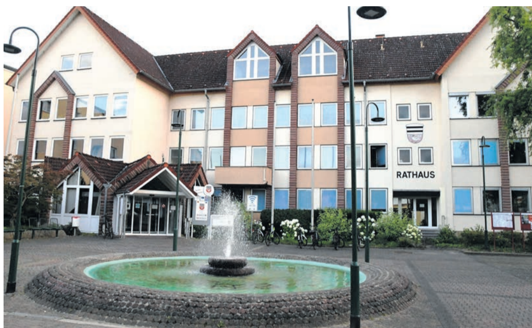
Das vor 60 Jahren erbaute Münsterer Rathaus ist in Sachen Brandschutz und Elektroinstallationen auf einem veralteten, teils sogar rechtlich problematischen Stand. Ein Neubau oder eine Sanierung stehen deshalb zur Debatte, ohne dass bislang die Finanzierung des Millionenprojekts geklärt wäre. Auch nach der Behandlung in der letzten Parlamentsitzung vor der Sommerpause tritt das Vorhaben auf der Stelle. (Foto: jedö)
