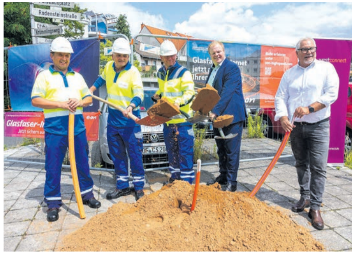
Spatenstich in Rodgau Nieder-Roden: Westconnect bringt Glasfasernetze zu weiteren Haushalten und Betrieben (v. l.): Siegfried Ossmann, Volker Schneider, Daniel Böttcher (Regionalmanager Westconnect), Max Breitenbach (Bürgermeister), Bardo Neuhäusel (Agentur für Wirtschaftsförderung und Stadtmarketing). (Foto: ah)
